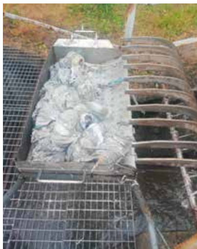
ŚMIECI WYŁAPYWANE NA KRATACH W OCZYSZCZALNI ŚCIEKÓW W SKOCZOWIE
