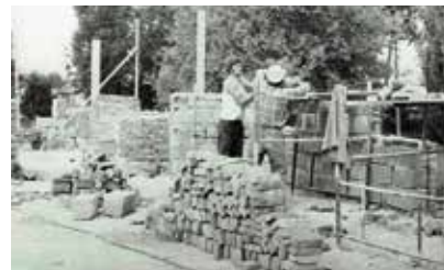
Budowa ośrodka zdrowia.
