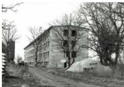
Budowa szkoły w Dębowcu (koniec lat 80).
