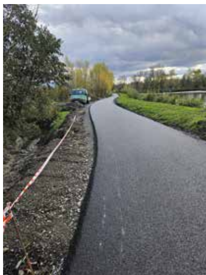
Budowa drogi Dębina - Simoradz
