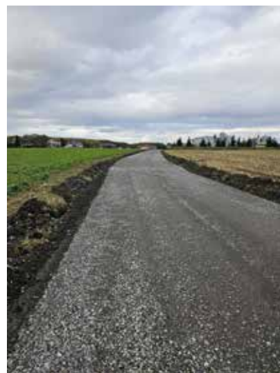
Budowa drogi Chodniki - Lipowa
